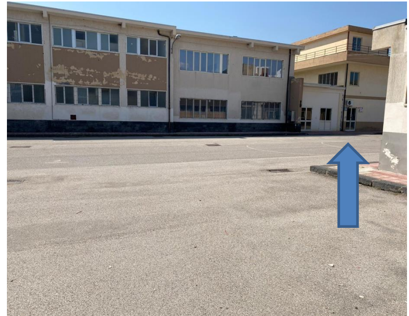
Piazzale accoglienza classi seconde – ingresso De Gasperi primo piano
